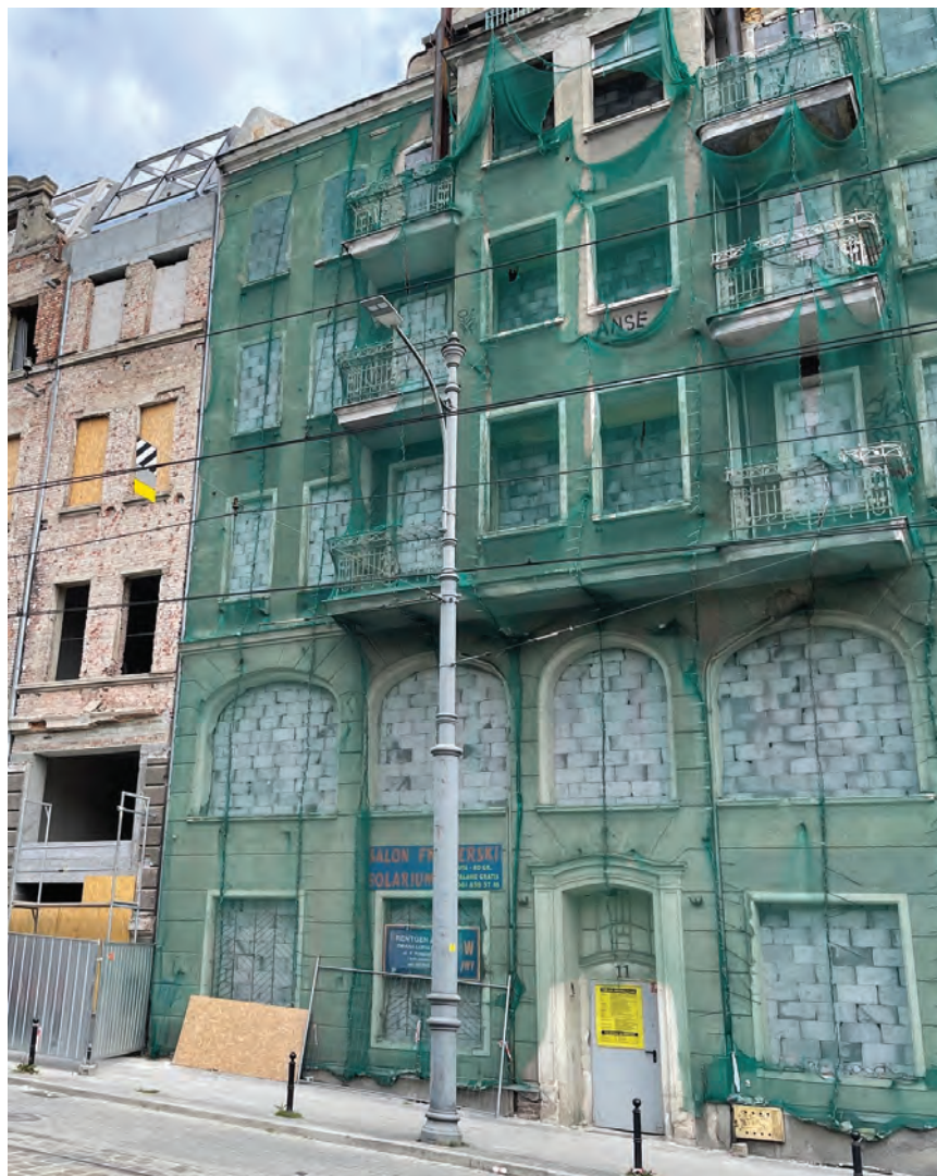
Remont i przebudowa budynków przy ulicy Podgórznej w Poznaniu. Fot. PINB
