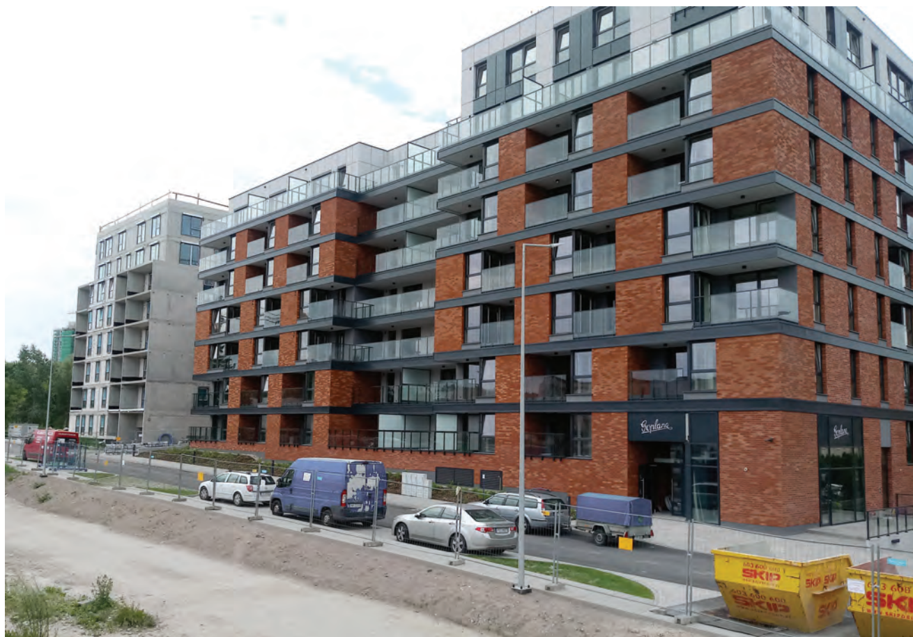
Budynek mieszkalny wielorodzinny przy ulicy św. Wawrzyńca 11 w Poznaniu. Teren dawnej Goplany. Fot. PINB
