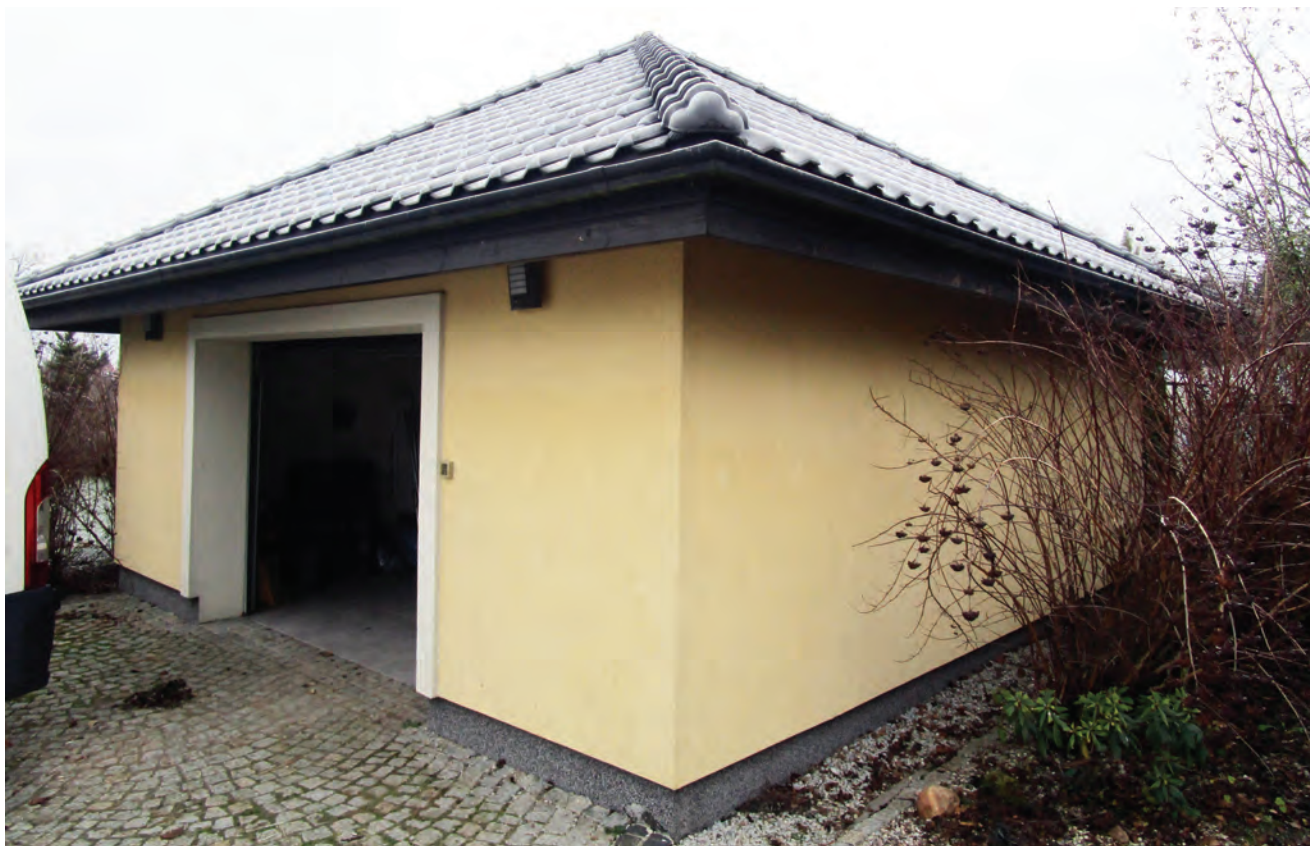
Samowola budowlana – wolno stojący garaż jednostanowiskowy. Fot. PINB Poznań
