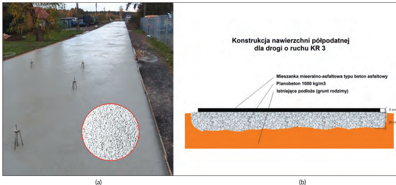
Rys. 1. Konstrukcja nawierzchni półpodatnej: (a) warstwa z pianobetonu i (b) schemat konstrukcji
