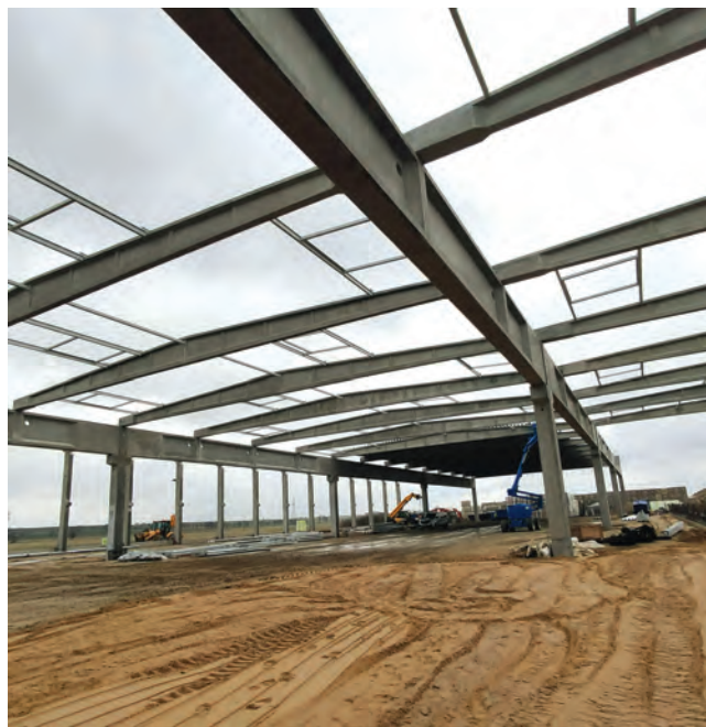
Rozbudowa budynku produkcyjno-magazynowego w Czachorowie.
