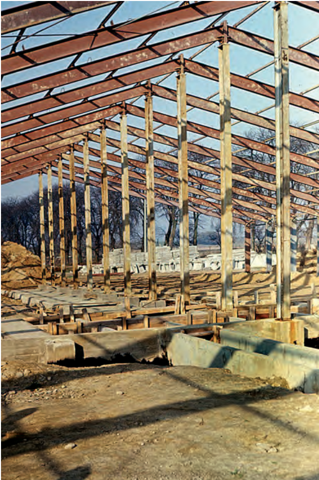
Ryc. 9. Montaż obory wznoszonej w systemie Fermstal. Fot. WŁ
