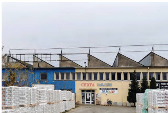
Ryc. 5. Dach pilasty nad halą WSK w Kaliszu. Fot. Andrzej Matysiak
