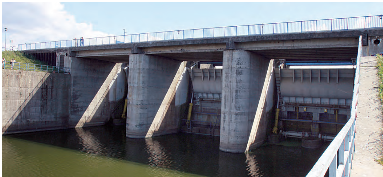
Ryc. 13. Jaz piętrzący wody Warty zbiornika Jeziorsko. Fot. ZS
