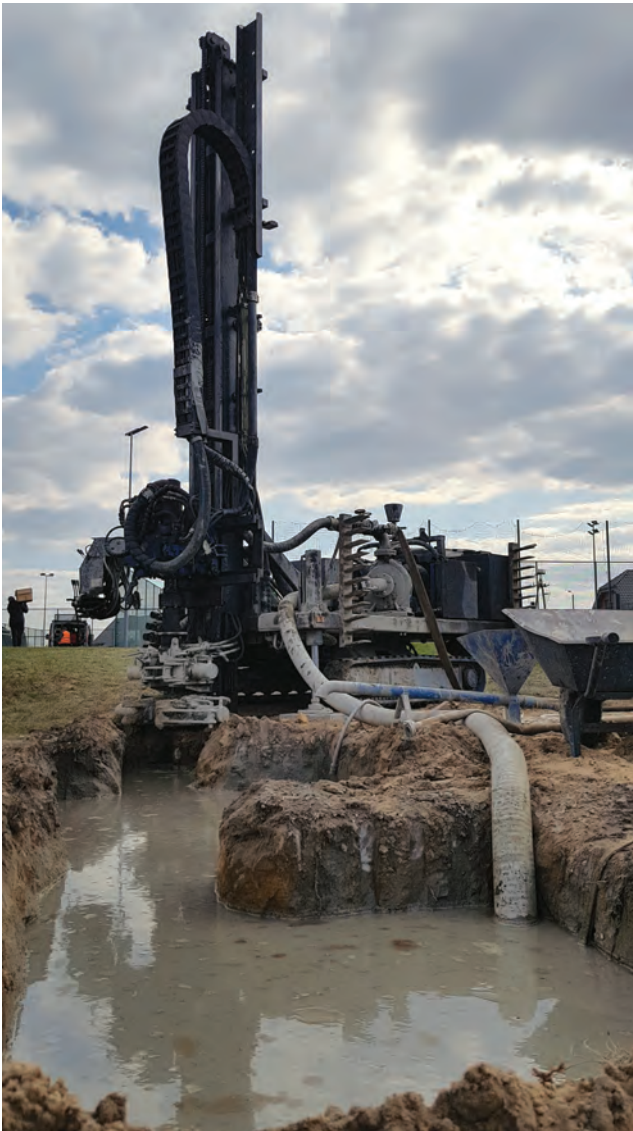
Ryc. 8. Wykonywanie odwiertów dla sond dolnego źródła z wykorzystaniem wiertnicy płuczki bentonitowej. Fot. WA
