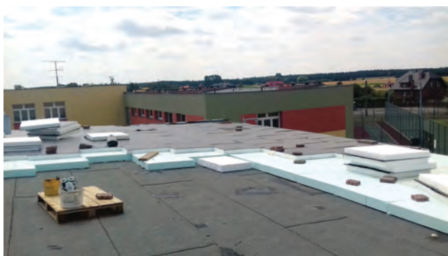
Ryc. 6. Ocieplenie dachu niewentylowanego za pomocą styropapy. Fot. WA
