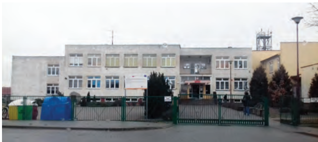
Ryc. 1. Elewacja wejściowa szkoły nie modernizowana od momentu budowy. Fot. Wioleta Alenowicz
