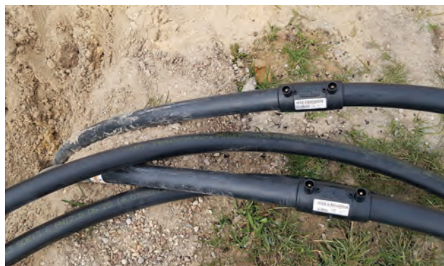
Ryc. 10. Elektrooporowe łączenie sond z dobiegami do studni zbiorczych. Fot. WA
