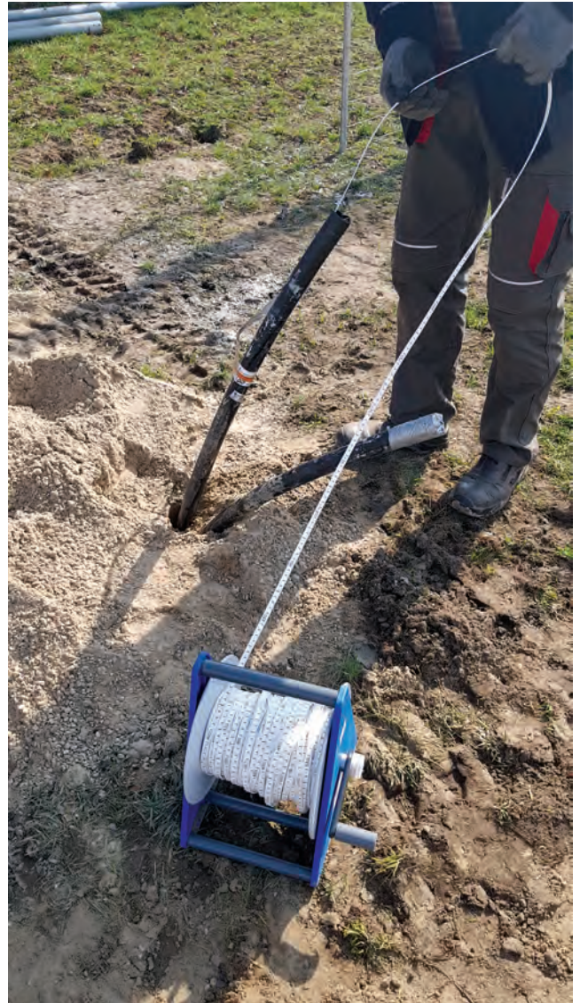
Ryc. 9. Pomiary długości zamontowanych sond. Fot. WA
