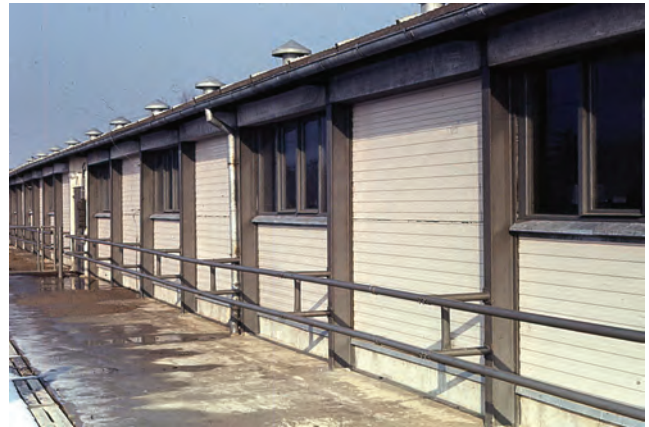
Ryc. 10. Ściany z płyt PW8-B owczarni zbudowanej w systemie Fermstal. Fot. WŁ
