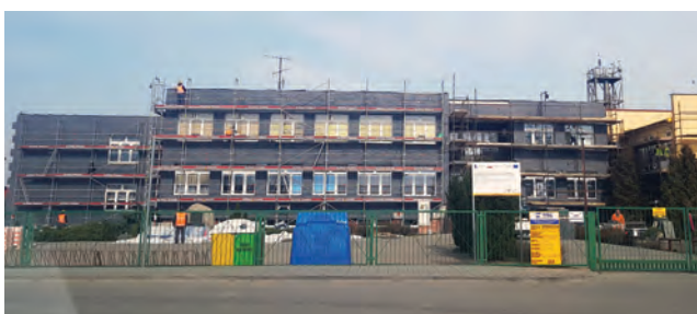
Ryc. 3. Podczas prowadzenia prac wejście główne do budynku było całkowicie zamknięte dla użytkowników szkoły, korzystali oni z wejścia bocznego, aby zabezpieczyć plac budowy. Fot. WA
