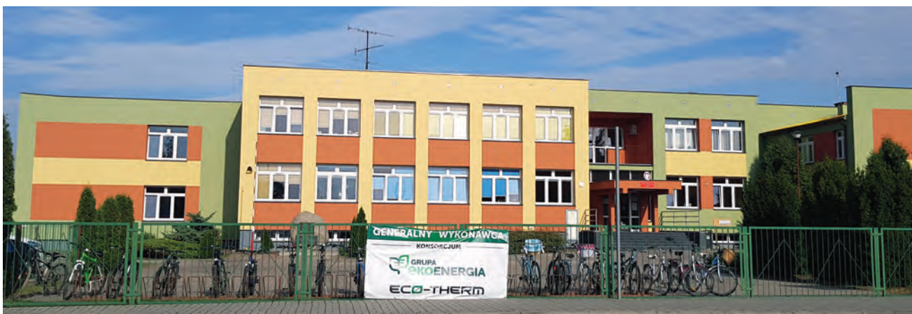
Ryc. 5. Elewacja wejścia głównego nabrała nowego wyglądu po wykonaniu prac dociepleniowych. Fot. WA
