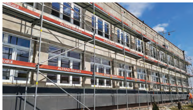
Ryc. 4. Układanie warstw elewacyjnych zgodnie z wytycznymi ETICS od dołu z zachowaniem tzw. mijanki między płytami minimum 15 cm. Fot. WA
