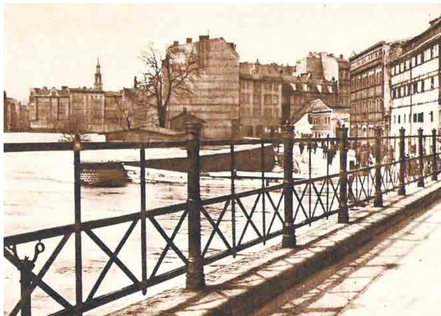
Ulica Czartoria podczas powodzi 1888 r. Ulicę chroni istniejący do dziś mur oporowy. Z lewej strony widoczne szandory zamykające ulicę.
